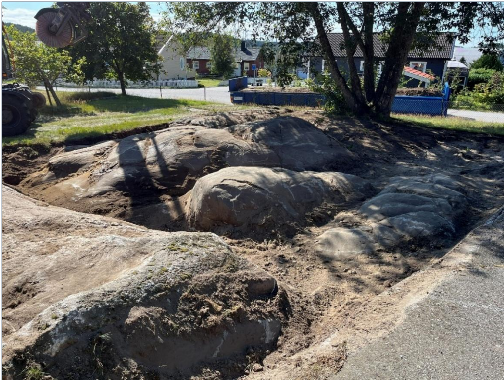
Figur 3. Schaktning utfördes ner till berg alternativt tills ingen synlig förorening kunde konstateras. Foto Enrecon.
