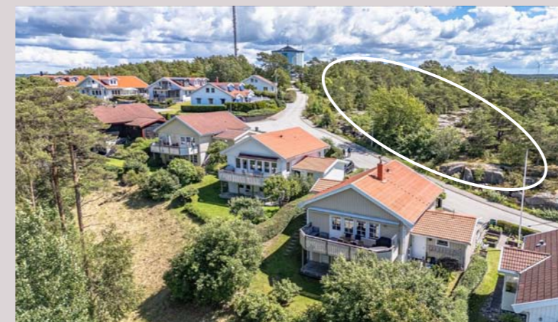
Befintlig bebyggelse med planområdet i vit cirkel. Vy från väster. Bild från Fastighetsbyrån
