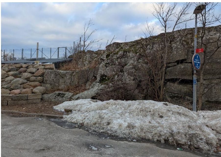
Figur 8. Gasolanläggningen, bergslänten öster om den framsprängda bergskärningen, vy mor nordväst.
