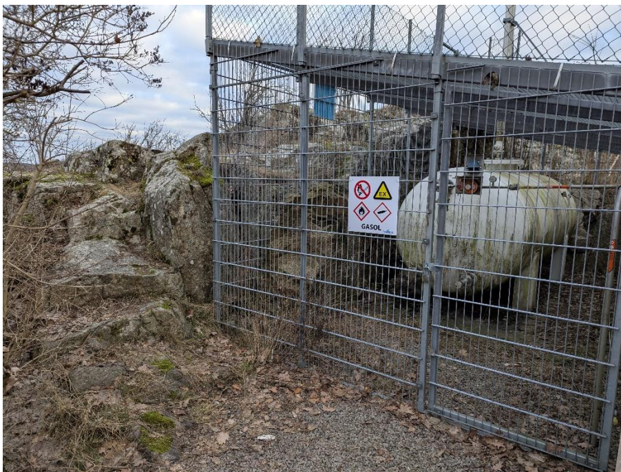
Figur 7. Gasolanläggningen, den framsprängda bergskärningen, vy mot norr.
